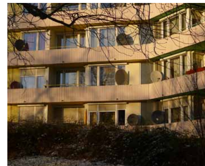
Abbildung 69: Herausforderung für die Fassadensanierung
