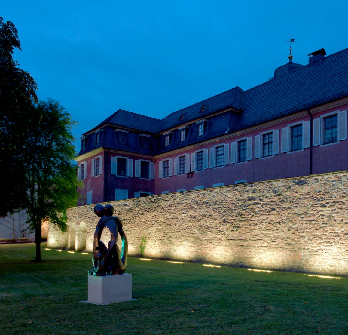
Halogenmetaldampflampen in Erd-einbauleuchten setzen helle Akzente an der Stadtmauer von Ladenburg.
