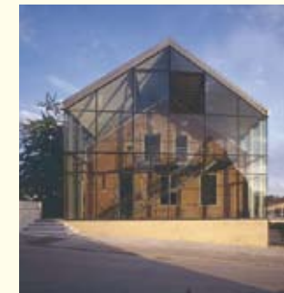
Umbau Alte Schule Neckarwestheim: Das Haus stammt aus dem Jahr 1890 und wurde 2002 erweitert. Der gläserne Erschließungsbau dient als Wärmepuffer für die ungedämmte Nordfas- sade des Altbaus. Über den großen Luftraum wird die kühle Luft aus dem Untergeschoss in die ober- en Geschosse gezogen, um eine natürliche Klima- tisierung zu erzeugen.
