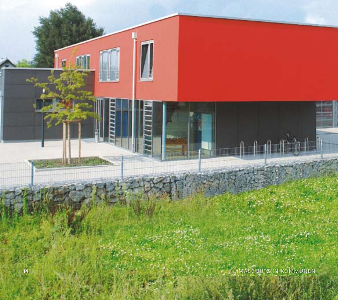
Projekt Scharnhauser Park in Ostfildern: Dezentral wird hier mit Holz- und Sonnenenergie ein ganzer Stadtteil versorgt. Inbetriebnahme war 2004. Großes Bild: Feuerwehration mit 70 kW Photovoltaikanlage. Kleines Bild: Holzheizkraftwerk mit 6,6 Megawatt Wärmeleistung und elektrischer Leistung von einem Megawatt.
