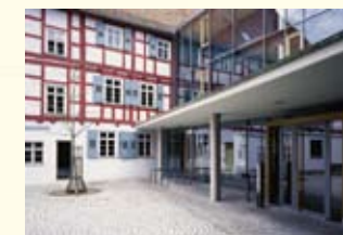
Umbau des Rathauses Adelsheim: Mit der umfassenden Sanierung des alten Rathauses (1619) und der Ergänzung um einen neuen Verwaltungsbau wurde Raum gewonnen und das Gebäude auf den energetisch neuesten Stand gebracht.
