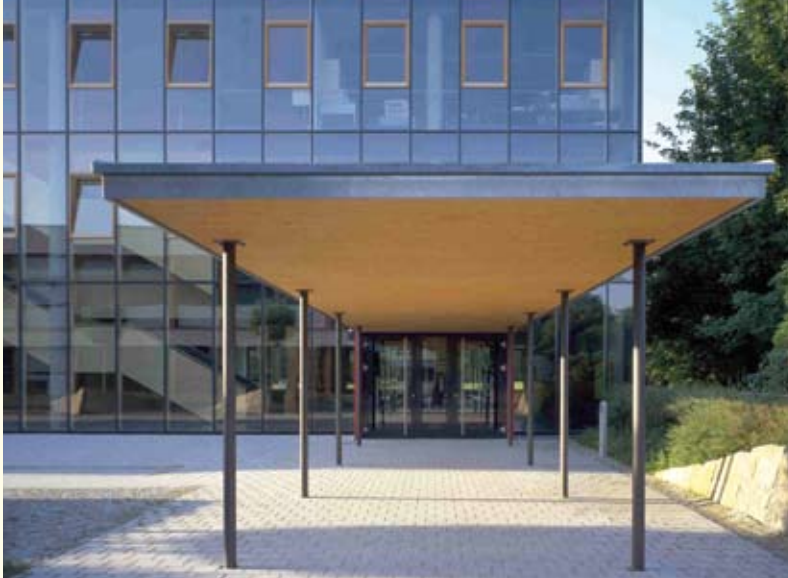
Erweiterungsbau der Gottlieb-Daimler-Schule II Sindelfingen.
