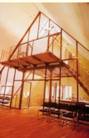
Umbau und Sanierung des Rathauses Hornberg: Im alten Rathaus gibt es jetzt eine neue zentrale Heizungsanlage mit Brennwerttechnik.
